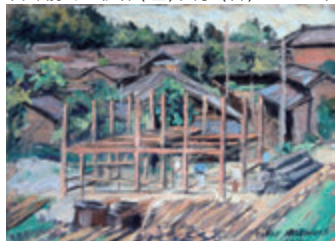
自邸Ⅲの新築現場 1914年
